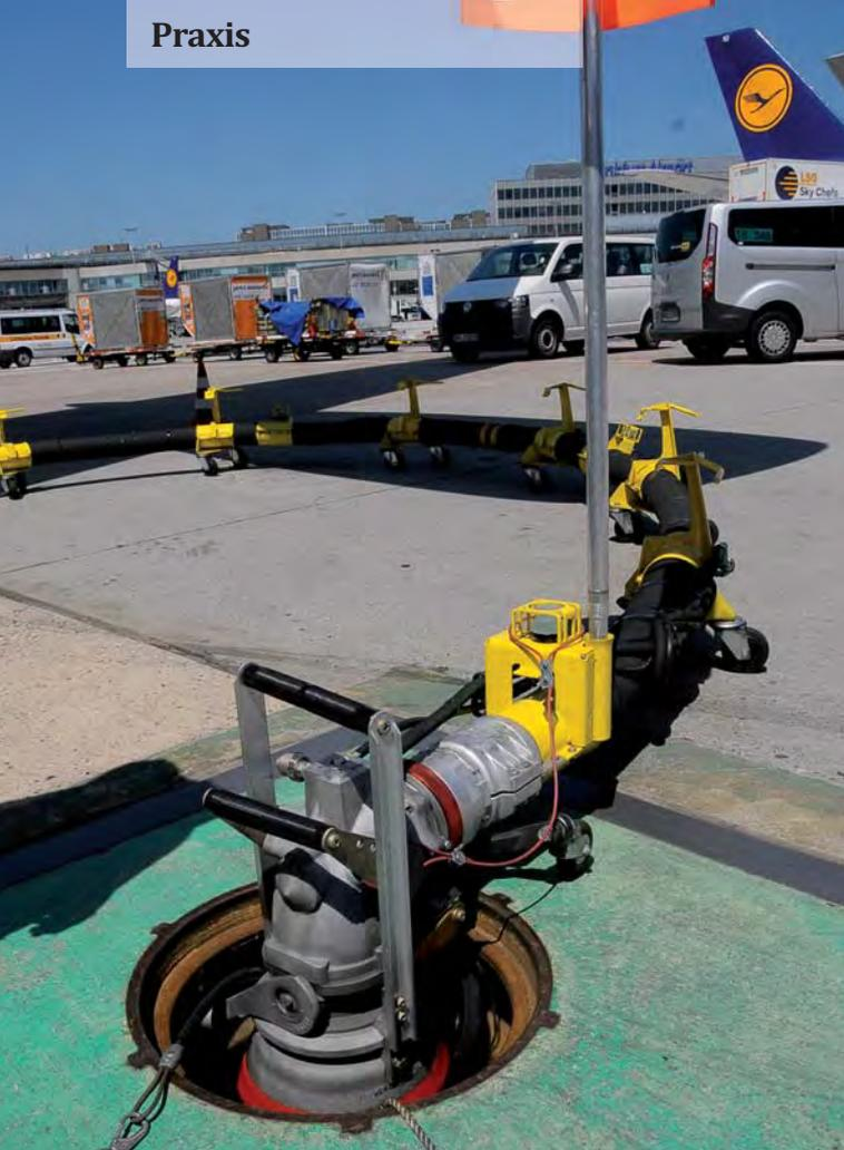
Aus dem Tanklager mit Pumpenstation und Filter wird das Kerosin mit dem erforderlichen Druck in unterirdische Leitungen zum Hydranten gepumpt. Daran wird das Fahrzeug (Dispenser) angekoppelt und übernimmt die Betankung des Flugzeugs. Am Dispenser wird geregelt, gemessen, gefiltert. Er selbst hat keinen Tank. Pit und Eingangscoupler ergeben einen sicheren Anschluss an den Hydranten. Foto: HHManz
